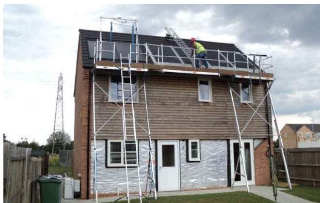
Fig. 3. Instalatorul de sisteme PV lucrează la înălțime
