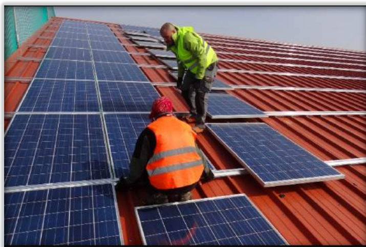
Fig. 5. Montarea modulelor pe structura de susținere a acoperișului Sursa: http://www.solarpanelsindustry.com/p/portfolio.html , (access: 20 September 2018).
