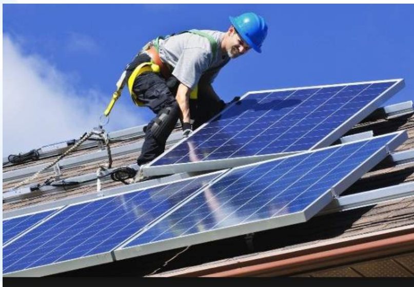
Fig. 2. Instalatorul de sisteme PV lucrează la o înălțime la instalarea modulului
