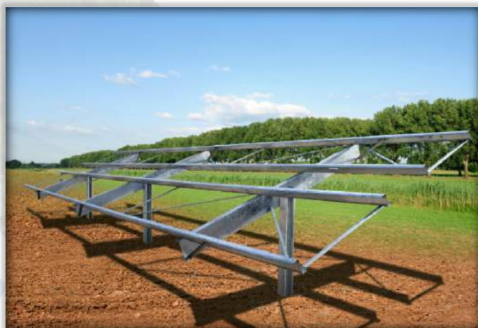
Fig. 4. Structura de susținere pe teren
