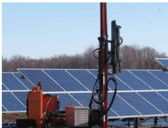
Fig. 1. Dispozitiv pentru realizarea pilonilor fundației
