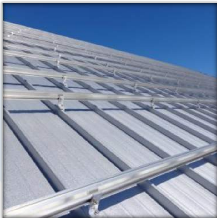
Fig. 3. Structura de susținere pe acoperiș
