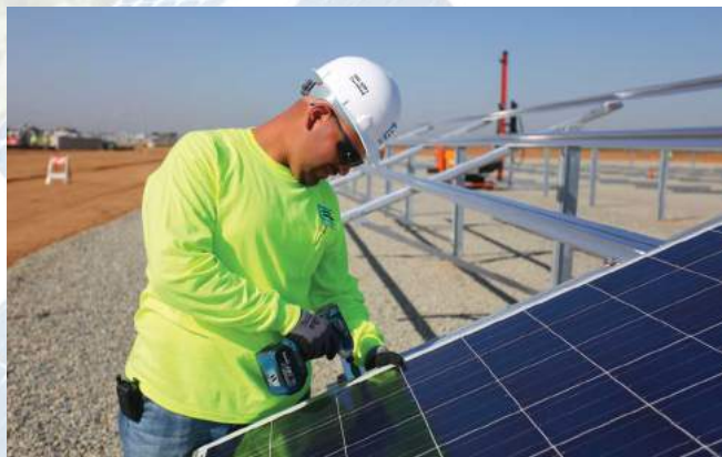
Fig. 1. Instalarea structurii mecanice pentru sistemul fotovoltaic la sol
