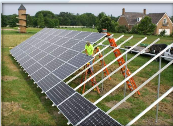
Fig. 6. Montarea modulelor pe structura de susținere a solului
