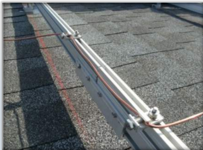
Fig. 7. Parte din instalația paratrăsnet
