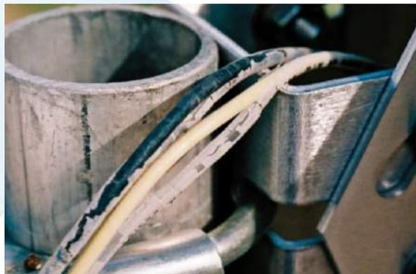
Fig. 4. Cables fotovoltaicos mal dispuestos
