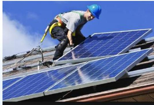
Fig. 2. Instalador de instalaciones fotovoltaicas trabajando a la altura en la instalación del módulo
