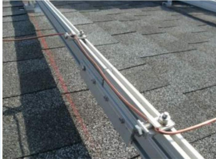
Fig. 7. Fragmento de la instalación de rayos en el sistema fotovoltaico
