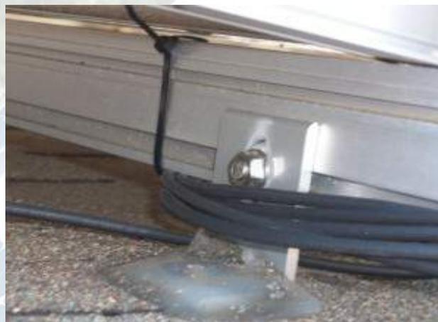
Fig. 5. Cables fotovoltaicos mal dispuestos sin la ruta del cable
