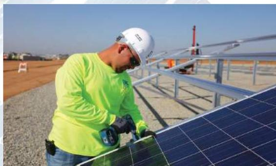
Fig. 1. Instalación de la estructura mecánica del sistema fotovoltaico terrestre
