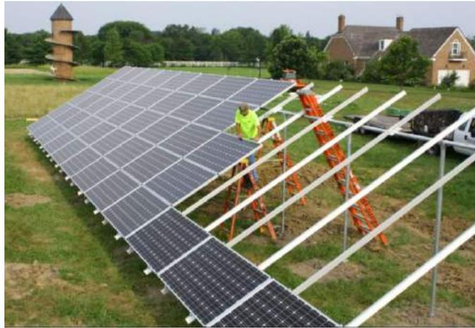
Fig. 6. Montaje de módulos sobre la estructura de soporte de tierra.
