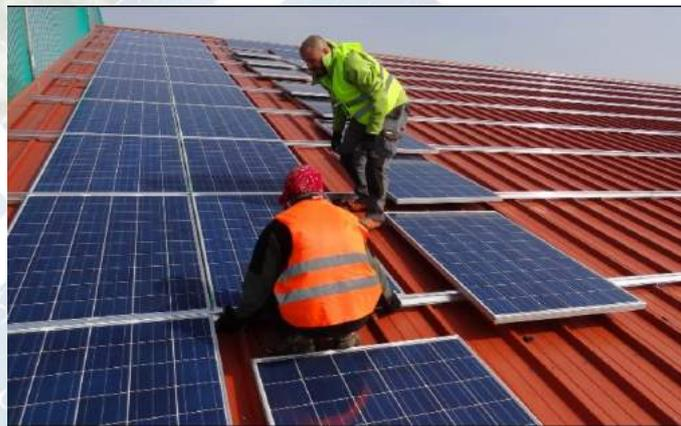
Fig. 5. Montaje de módulos sobre la estructura de soporte de techo
