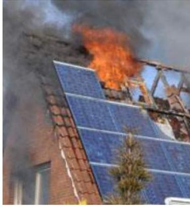
Fig. 7. Incendio del generador fotovoltaico
