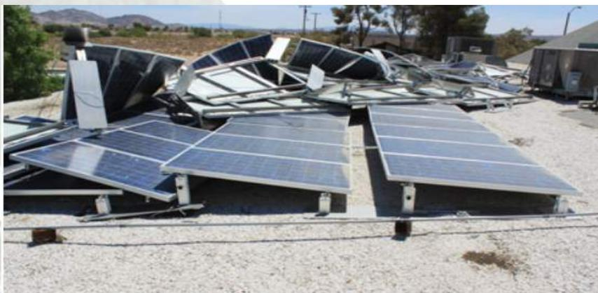
Fig. 3. Daño del generador fotovoltaico bajo la influencia del viento
