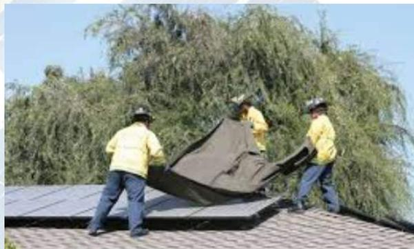
Fig. 4. Protección del módulo fotovoltaico con la inclinación
