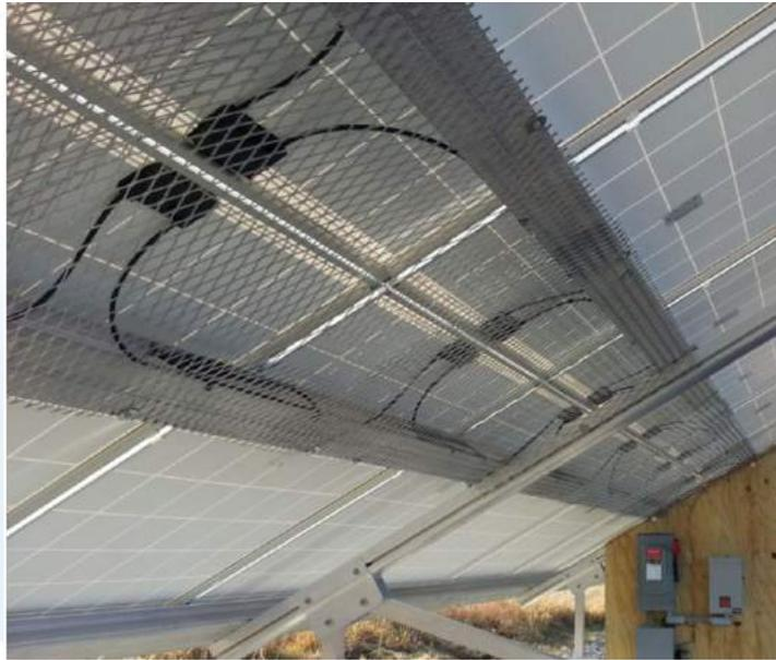
Fig. 6. Conexión correcta de los cables fotovoltaicos mediante conectores
