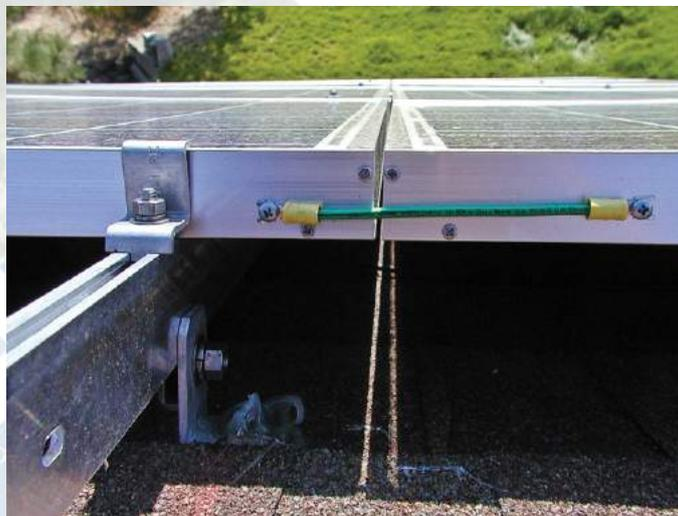
Fig. 7. Conexión de los potenciales de equalización de la puesta a tierra del módulo en sistemas fotovoltaicos
