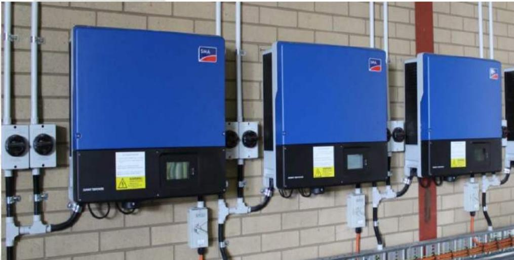
Fig. 10. Montaje del inversor.
