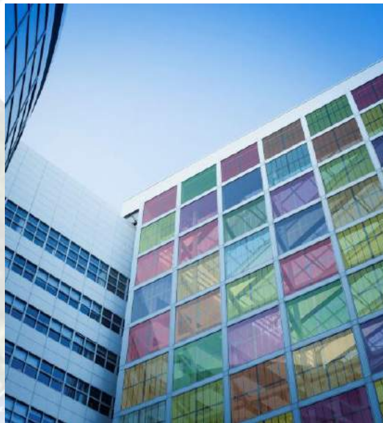
Εικόνα 8. Σύστημα συναρμολόγησης ενσωματωμένο στο κτίριο BIPV
