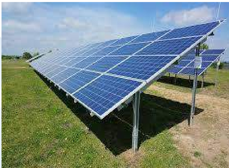
Εικόνα 11. Σύστημα ελεύθερης εγκατάστασης (Free-standing system)
