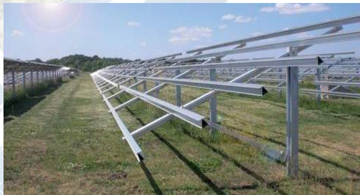
Εικόνα 6. Παράδειγμα συστήματος συναρμολόγησης σε έδαφος
