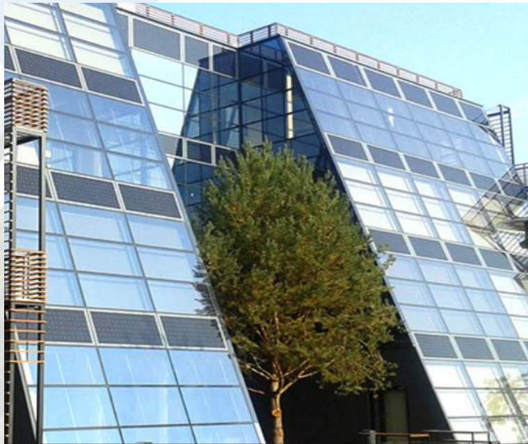
Εικόνα 10. Ενσωματωμένες φωτοβολταϊκές εγκαταστάσεις (Building-Integrated Photovoltaics BIPV) Πηγή: http://www.wfosigw.lodz.pl [πρόσβαση: 10 Μαΐου 2018]
