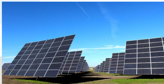
Fig. 7. Sistema de montaje ejemplar basado en seguidores
