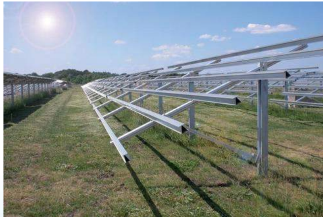
Fig. 6. Ejemplo de un sistema de montaje en tierra
