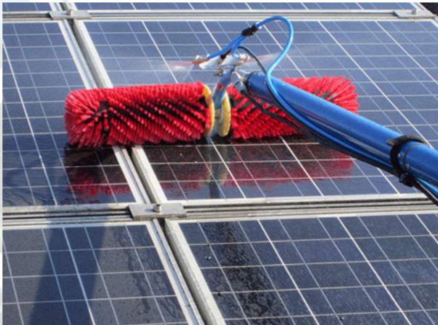
Fig. 6. Lavado de la instalación fotovoltaica
