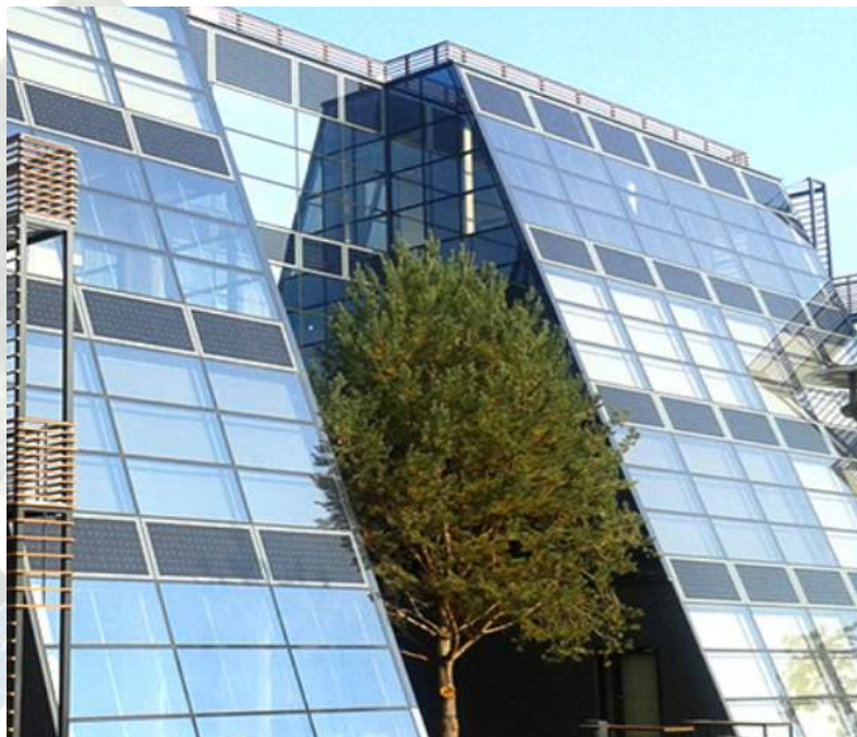
Fig. 10. Fotovoltaica integrada en edificios (BIPV)
