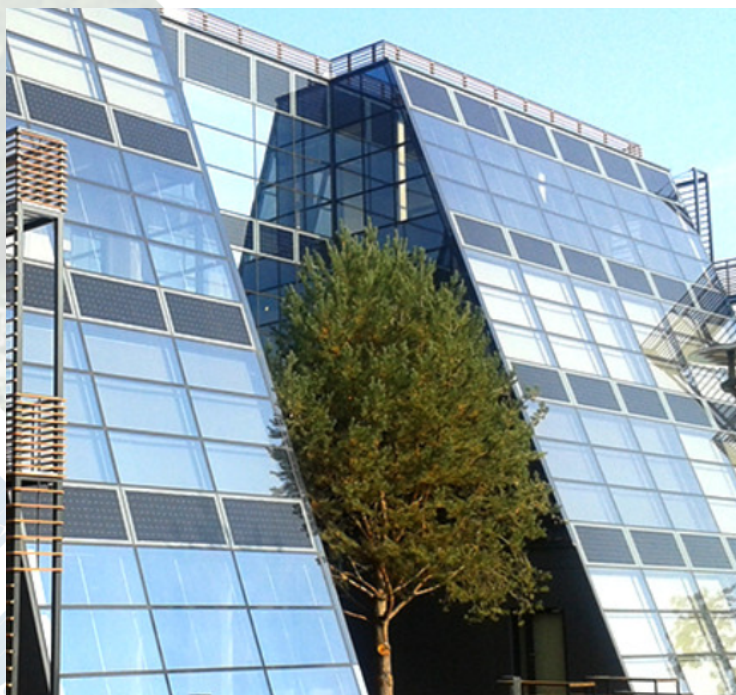
Rys. 10. System fotowoltaiczny zintegrowany z budynkiem BIPV
