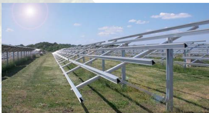
Rys. 6. Przykład naziemnego systemu montażowego
