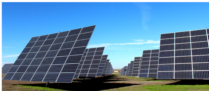
Rys. 7. Przykładowy system montażowy oparty na trackerach
