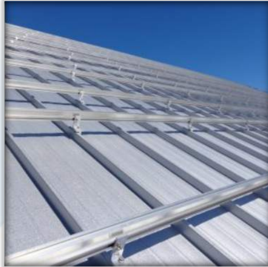
Εικ. 3. Παραδειγματική δομή στήριξης στην οροφή
