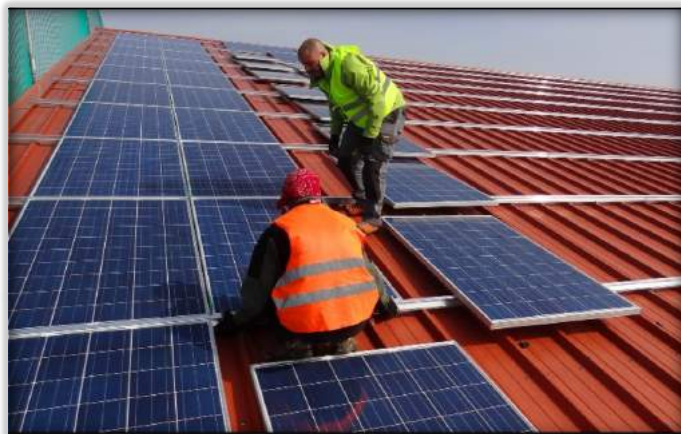
Εικ. 5. Συναρμολόγηση μονάδων στην υποστηρικτική δομή της οροφής
