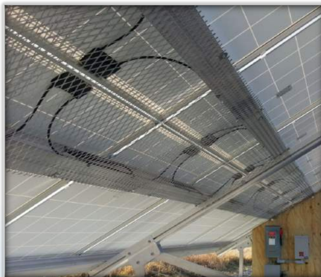
Εικ. 6. Ορθή σύνδεση των φωτοβολταϊκών συρμάτων με την χρήση plug connectors Πηγή: https://www.homepower.com/articles/solar-electricity/equipment-products/array-wire-management , πρόσβαση 20 Σεπτεμβρίου 2018).
