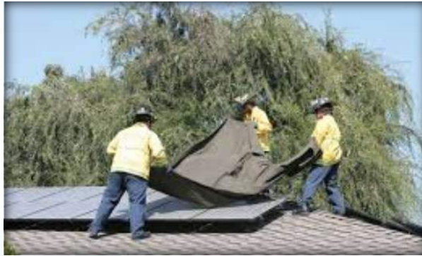
Εικ. 4. Προστασία της φωτοβολταϊκής μονάδας με κάλυψη της Πηγή: http://securedsolar.com/why/ , (πρόσβαση: 20 Σεπτεμβρίου 2018).
