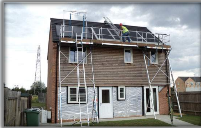
Εικ. 3. Εγκαταστάτης φωτοβολταϊκού συστήματος που εργάζεται σε ύψος Πηγή: https://easi-dec.co.uk/products/solar-access-system , (πρόσβαση: 20 Σεπτεμβρίου 2018).
