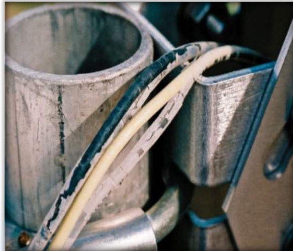
Εικ. 4. Λανθασμένη τοποθέτηση φωτοβολταϊκών καλωδίων
