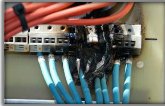
Εικ. 8. Πυρκαγιά στον πίνακα ελέγχου AC σε μια φωτοβολταϊκή εγκατάσταση
