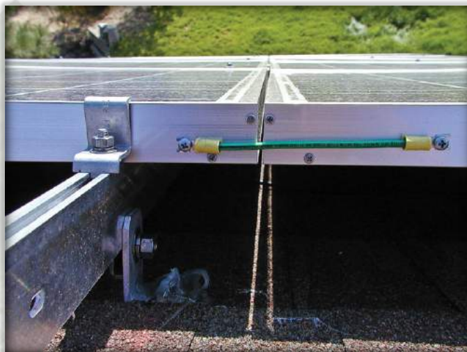
Εικ. 7. Συνδέσεις δυναμών εξισορρόπησης της γείωσης της μονάδας σε φωτοβολταϊκά συστήματα Πηγή: https://solarprofessional.com/articles/design-installation/common-residential-pv-system-code-violations#.W9Hs1nszaro , (πρόσβαση: 20 Σεπτεμβρίου 2018).
