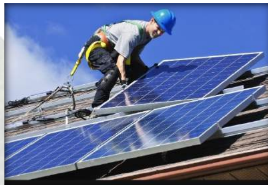
Εικ. 2. Εγκαταστάτης φωτοβολταϊκών εργάζεται σε ύψος σε μια φωτοβολταϊκή εγκατάσταση Πηγή: http://theconversation.com/why-rooftop-solar-is-disruptive-to-utilities-and-the-grid-39032 , (πρόσβαση: 20 Σεπτεμβρίου 2018).
