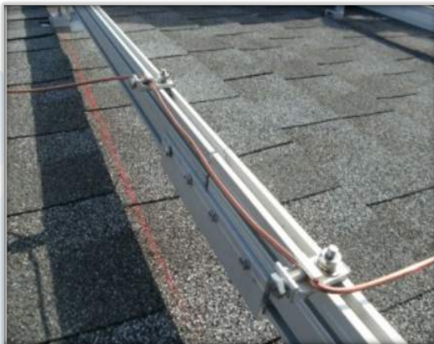
Εικ. 8. Τμήμα της εγκατάστασης αστραπής στο φωτοβολταϊκό σύστημα
