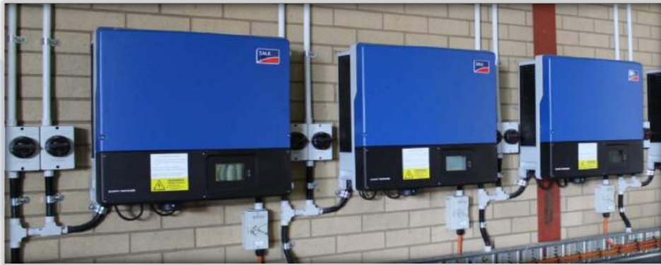
Εικ. 10. Συναρμολόγηση του μετατροπέα
