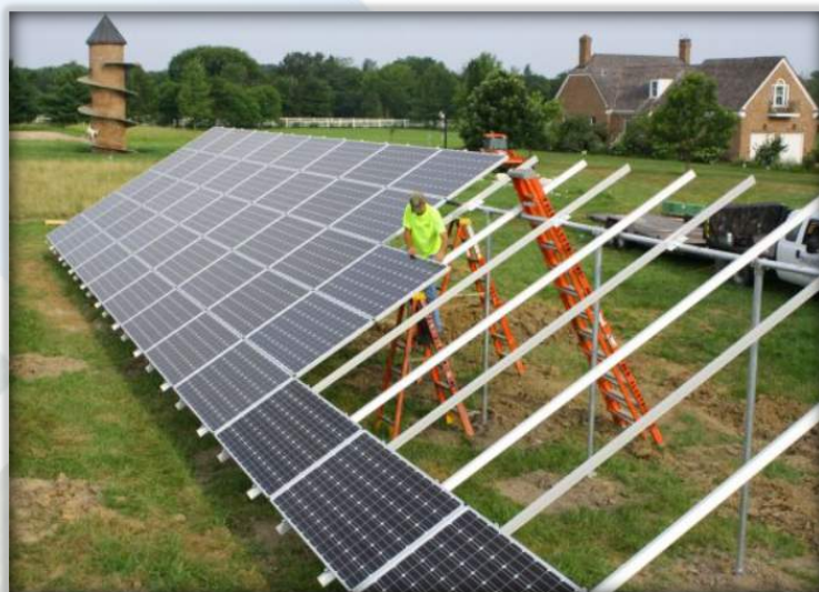
Εικ. 6. Συναρμολόγηση των μονάδων σε υποστηρικτική δομή εδάφους
