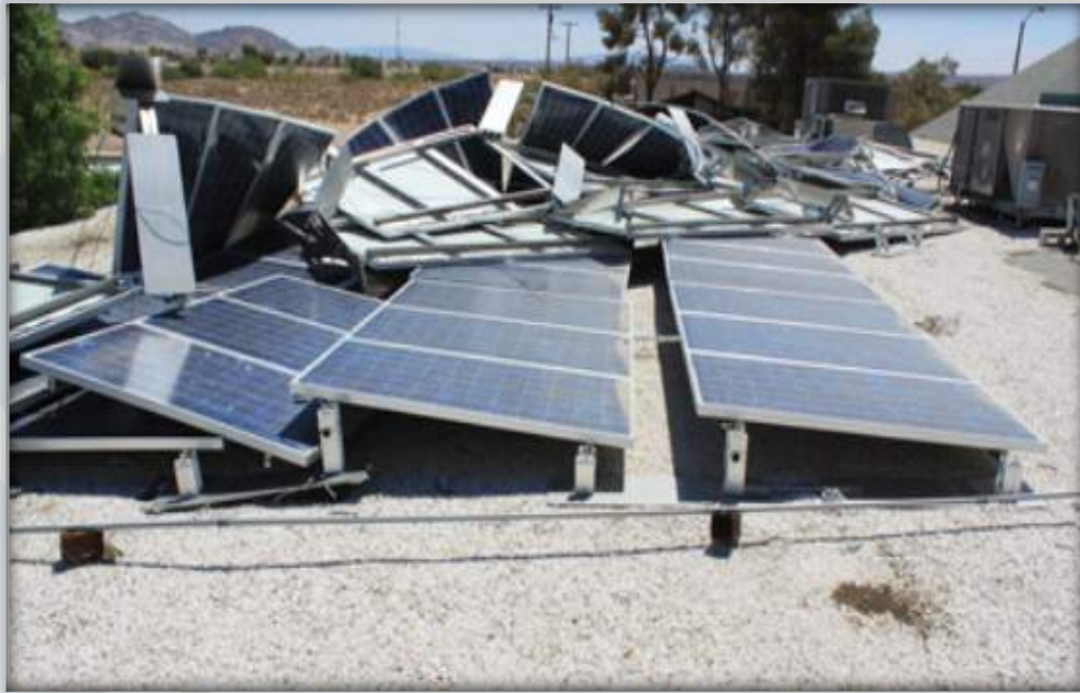
Εικ. 3. Βλάβη στη φωτοβολταϊκή γεννήτρια λόγω ανέμου
