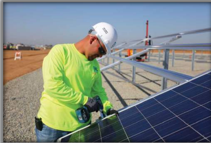
Εικ. 1. Εγκατάσταση της μηχανικής δομής για ένα φωτοβολταϊκό σύστημα εδάφους. Πηγή: https://solarprofessional.com/articles/products-equipment/racking/ground-mount-pv-racking-systems#.W7uZynszapo , (πρόσβαση: 20 Σεπτεμβρίου 2018).
