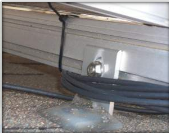
Εικ. 5. Λανθασμένα τοποθετημένα φωτοβολταϊκά σύρματα χωρίς το cable route
