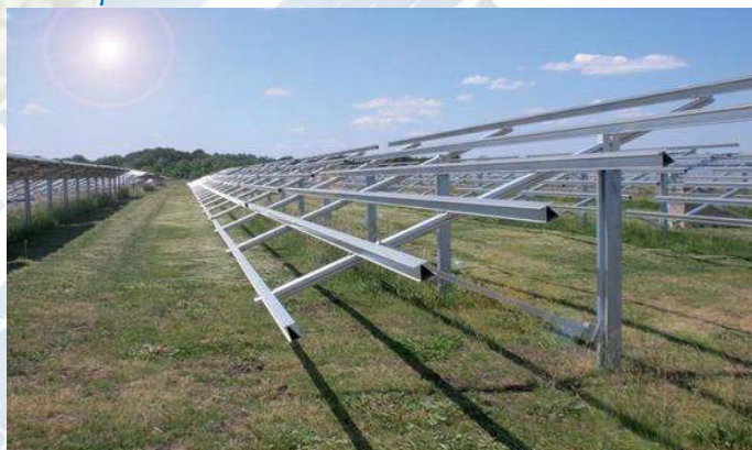
Fig. 6. Exemplu de sistem de asamblare la sol
