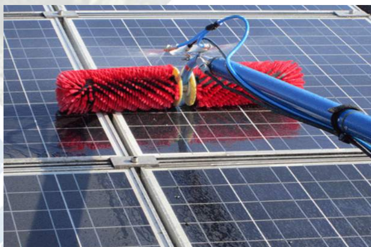
Fig. 6. Spălarea instalației fotovoltaice
