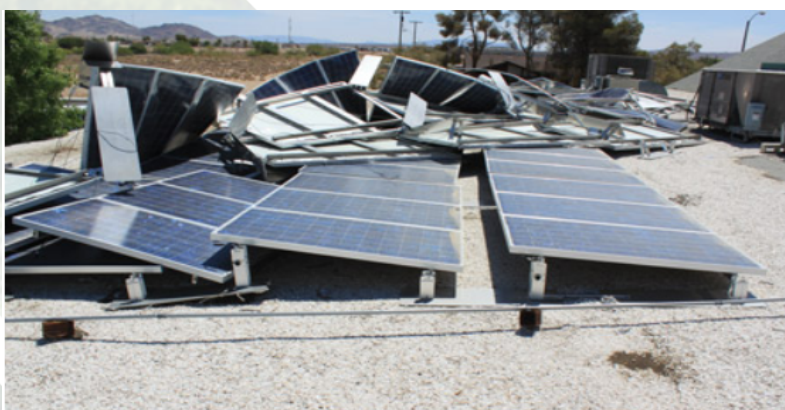
Rys. 3. Uszkodzenie generatora PV pod wpływem wiatru
