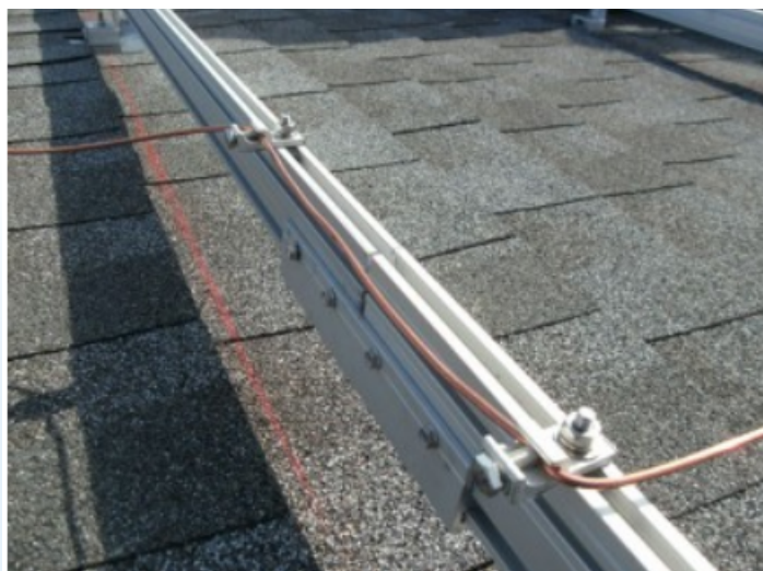
Rys. 7. Fragment instalacji odgromowej w systemie PV
