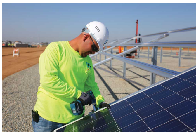
Rys. 1. Montaż konstrukcji mechanicznej dla naziemnego systemu PV
