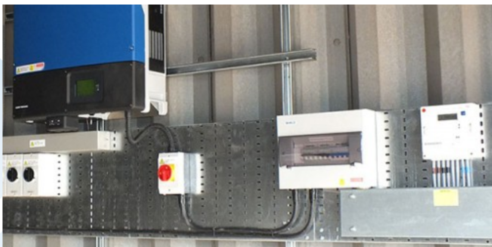
Rys. 11. Zabezpieczenia AC
