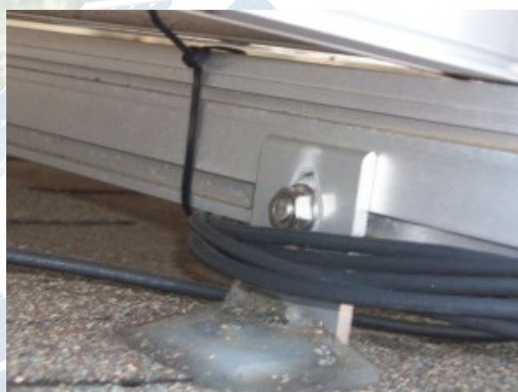
Rys. 5. Ułożone kable PV bez trasy kablowej
