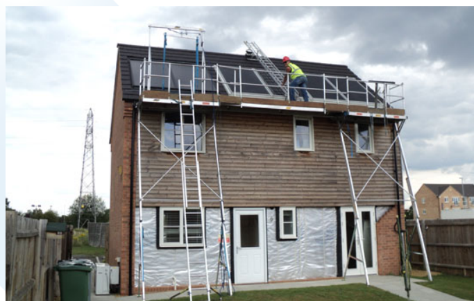
Rys. 3. Instalator systemu PV pracujący na wysokości
