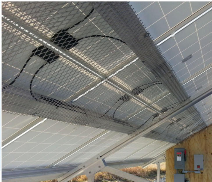
Rys. 6. Prawidłowe podłączenie kabli PV przy pomocy złącz wtykowych
