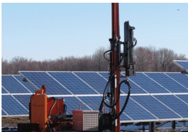
Rys. 1. Kafar do wbijania konstrukcji gruntowych
