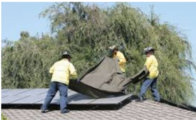
Rys. 4. Zabezpieczanie modułów PV plandeką Źródło: http://securedsolar.com/why/ , (dostęp: 20.09.2018).
