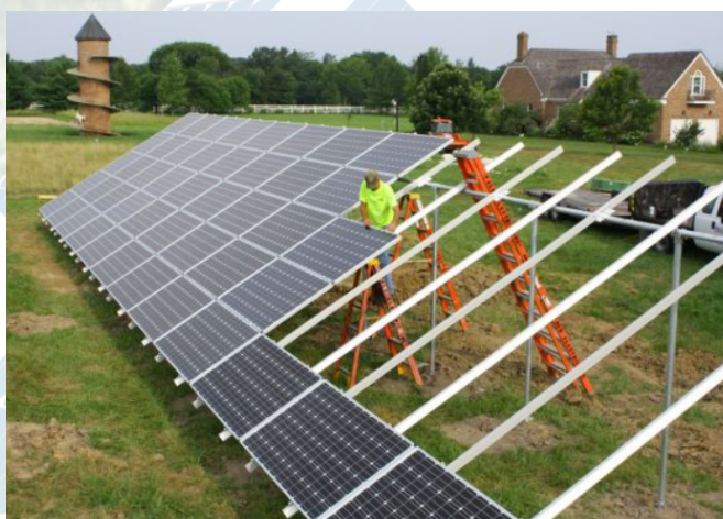
Rys. 6. Montaż modułów na gruntowej konstrukcji wsporczej
