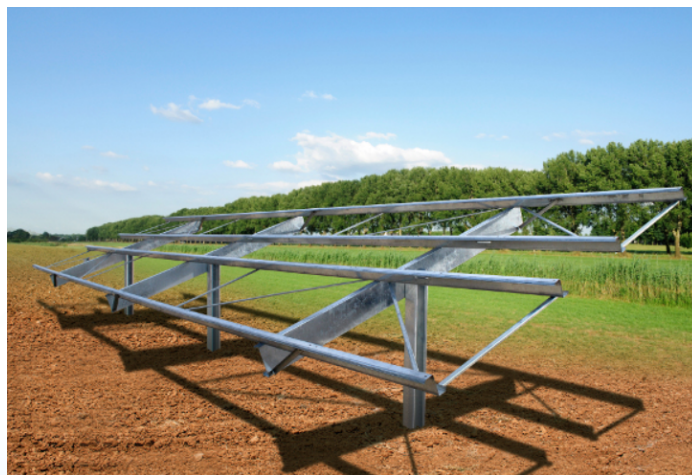
Rys. 4. Instalacja wsporcza na gruncie
