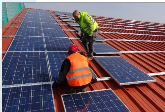
Rys. 5. Montaż modułów na dachowej konstrukcji wsporczej
