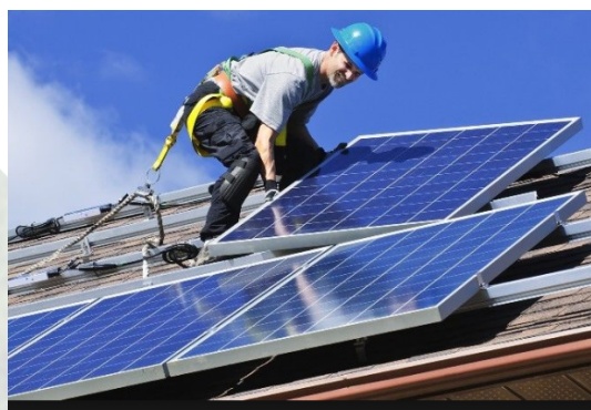
Rys. 2. Instalator systemu PV pracujący na wysokości przy montażu modułów
