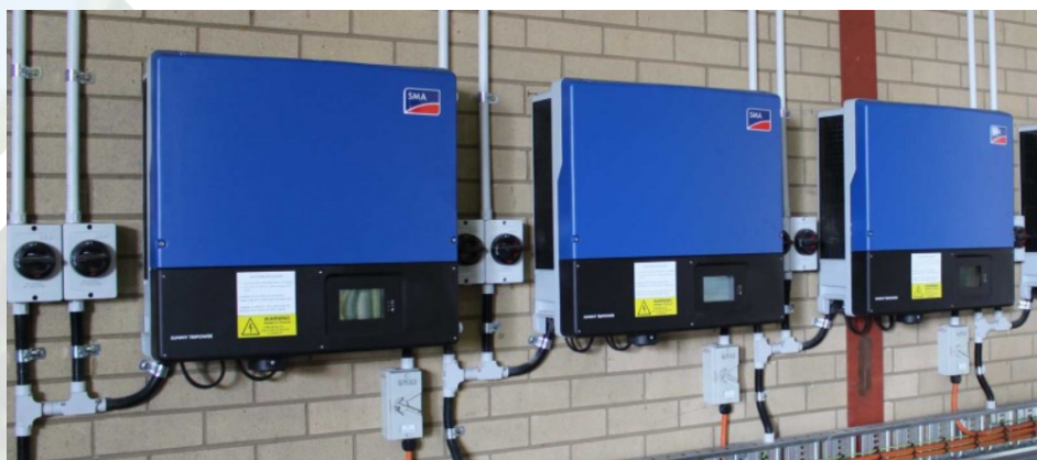
Rys. 10. Montaż falownika
